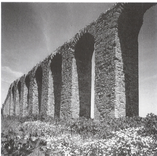
Römischer Aquädukt (Wasserstrasse) zwischen Zaghouan und Karthago. Erbaut um 69 - 79 n. Chr. durch den römischen Kaiser Vespasian. Gebrannte Tongiebel, mit Mörtel und Asphalt verbunden.
