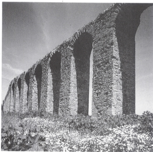
Römischer Aquädukt (Wasserstrasse) zwischen Zaghouan und Karthago. Erbaut um 69 - 79 n. Chr. durch den römischen Kaiser Vespasian. Gebrannte Tonziegel, mit Mörtel und Asphalt verbunden.
