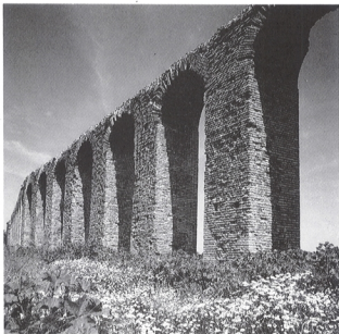
Römischer Aquädukt (Wassertrasse) zwischen Zaghouan und Karthago. Erbaut um 69-79 n. Chr. durch den römischen Kaiser Vespasian. Gebrannte Tonziegel, mit Mörtel und Asphalt verbunden.
