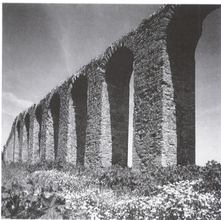
Römischer Aquädukt (Wasserstrasse) zwischen Zaghouan und Karthago. Erbaut um 69 - 79 n. Chr. durch den römischen Kaiser Vespasian. Gebrannte Tongegel, mit Mörtel und Asphalt verbunden.
