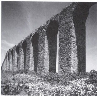
Römischer Aquädukt (Wasserstrasse) zwischen Zaghouan und Karthago. Erbaut um 60 - 70 n. Chr. durch den römischen Kaiser Vespasian. Gebrannte Tongiebel, mit Mörtel und Asphalt verbunden.
