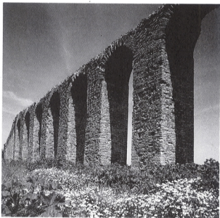
Römischer Aquädukt (Wasserstrasse) zwischen Zaghoua und Karthago. Erbaut um 69 - 79 n. Chr. durch den römischen Kaiser Vespasian. Gebrannte Tonstege, mit Mörtel und Asphalt verbunden.
