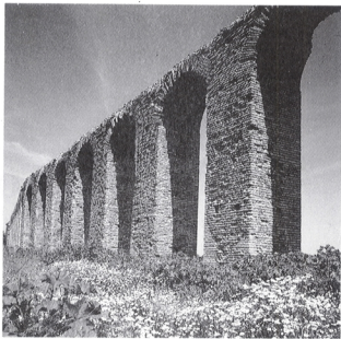
Römischer Aquädukt (Wasserstrasse) zwischen Zugzwang und Karthago. Erbaut um 69 - 79 n. Chr. durch den römischen Kaiser Vespasian. Gebrannte Tonziegel, mit Mörtel und Asphalt verbunden.
