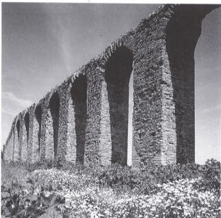
Römischer Aquädukt (Wasserstrasse) zwischen Zaghouan und Karthago. Erbaut um 69-79 n. Chr. durch den römischen Kaiser Vespasian. Gebrannte Ziegel, mit Mörtel und Asphalt verbunden.
